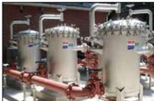
ハリケーンフィルターの20ミクロン、5ミクロンで2段に沈降物を濾過し、最後に1ミクロンポリプリーツフィルターで、クリプトスポリジウムを低減させています。
