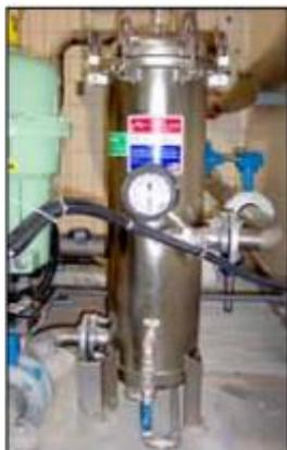
ハリケーンフィルターを固形物除去用に稼働させ、満足のいく性能を発揮しています。また、ここでは25回以上洗浄・再利用されています
