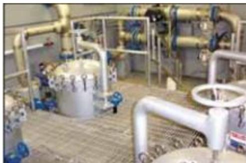
4台のハリケーンSBハウジングが並列に設置され、5ミクロンカートリッジを使い、727m<sup>3</sup>/Hrで運転されています。
