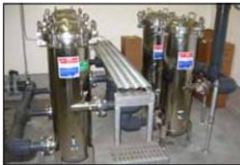
日本でいう簡易水道のような施設。5ミクロンのHURI×170FLを2台で処理した後、アブソリュート1ミクロンの同型ハウジング3台で処理しています。
