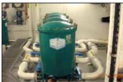
4台のHIF-200FLに耐腐食性コーティングを施し、大型クーラーの海水淡水化(RO)の前濾過に7年以上問題なく使用しています
